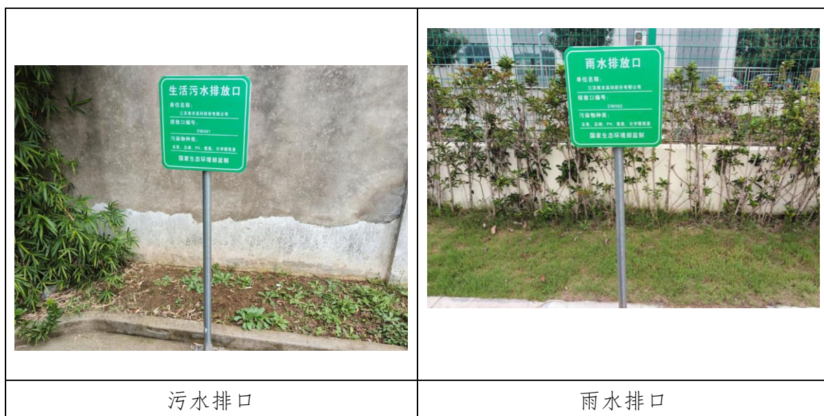
图 4.1-2 废水处理设施图片
